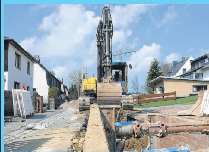
Am Moosbach in Grünhain verlegt der ZWW derzeit für 602,1 T€ auf einer Länge von 315 Metern einen Schmutz- und Regenwassersammler und wechselt auf gleicher Länge die Trinkwasserleitung aus. Insgesamt erhalten damit 40 Grundstücke einen Abwasservollanschluss. Als Baufertigstellung plant der ZWW Anfang August 2018.
